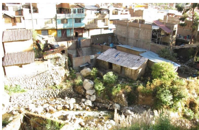
Foto: Viviendas expuestas al riesgo de inundación Quebrada Disparate-Huancavelica
